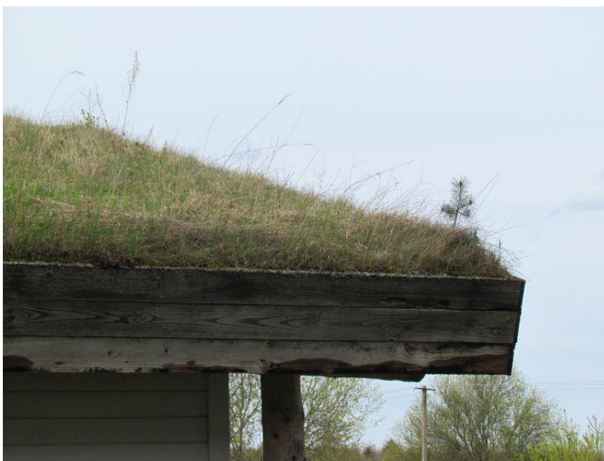
Joonis 51. Haljaskatusel kasvama läinud puuvõsud tuleks eemaldada võimalikult varakult.
