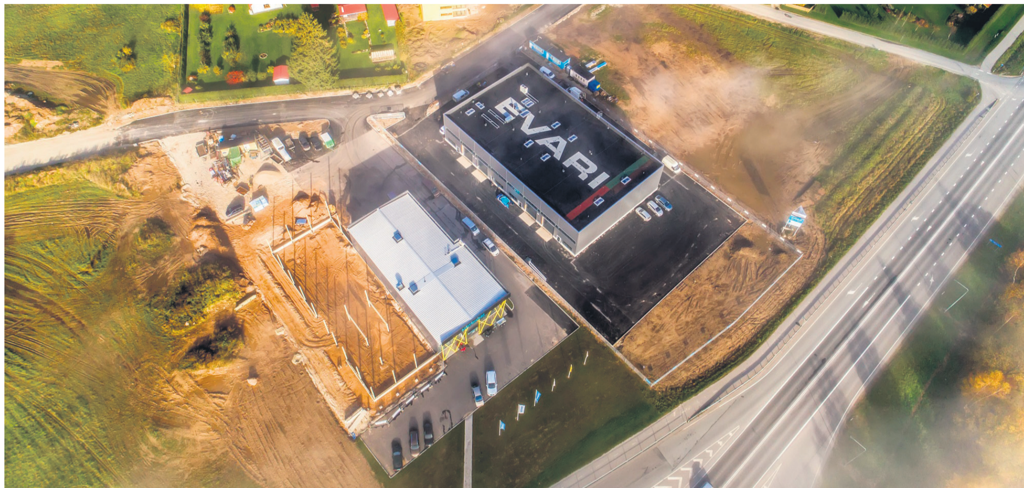
▲ Oma uue hoone katusele paigutatud Evari Ehitus firma reklaam.
