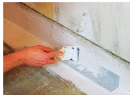
4. Asetada Kiilto Butüüllint märkele Kiilto Keramixi hüdroisolatsioonimastiksile ja pintseldada lint mastiksiga üle.
