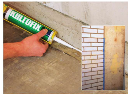
3. Kui vuuk on laiem kui 5 mm, saab selle täita hermeetikuga KiiltoFix Masa, uretaanvahuga või vuugitihendiga.
